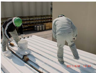
2層塗り作業中
